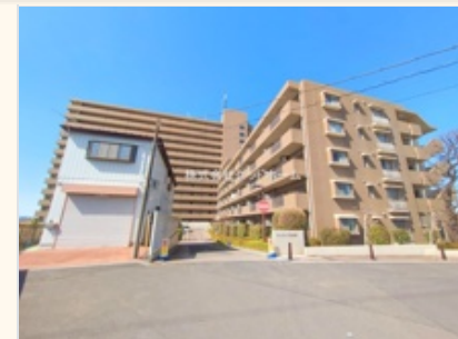
現況:外観 ('25/03/07撮影)
