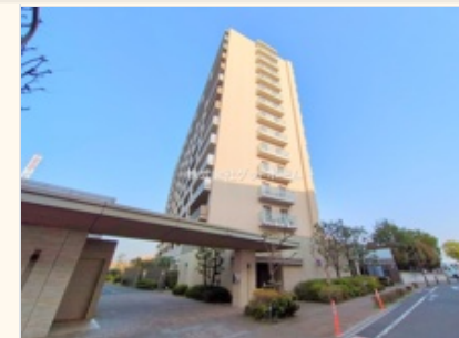
現況:外観 ('25/03/26撮影)
