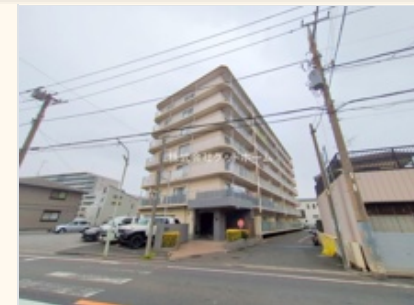
現況:外観 ('25/03/12撮影)
