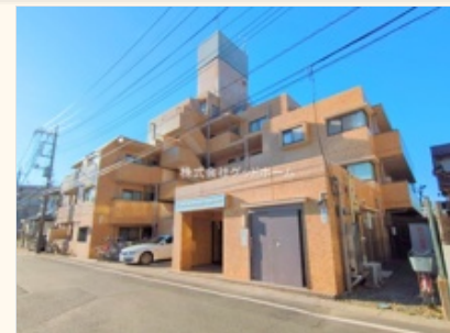
現況: 外観 ('25/01/29撮影)
